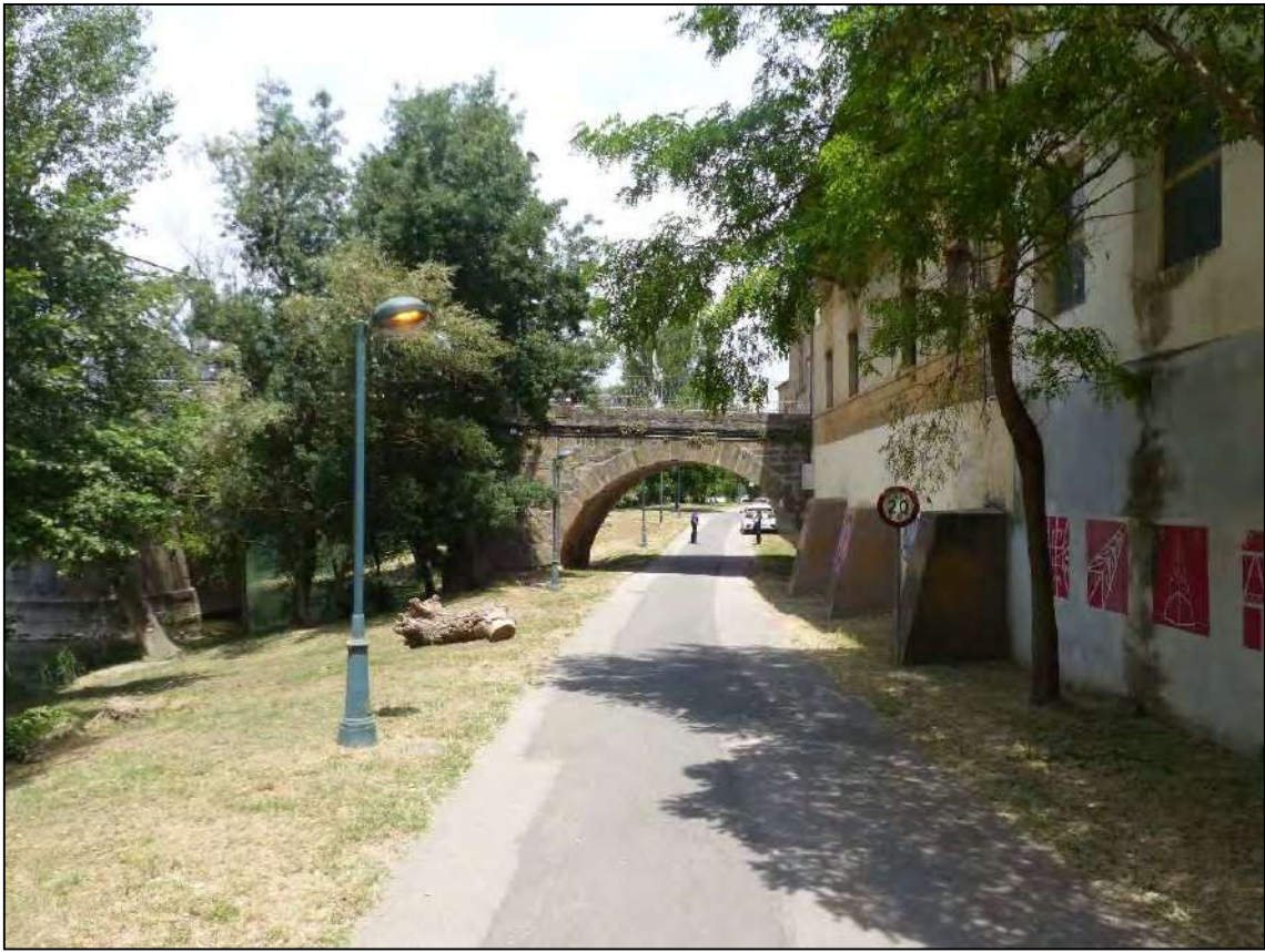
Figura 42. Fotografías tomadas en la zona del Paseo de Cantolagua, que marca el acceso del casco urbano del cauce del Aragón. El punto más bajo de este paseo se encuentra bajo el puente de la carretera NA-8603. La segunda fotografía muestra los puntos [huecos] de una pared de piedra de esta calle que son alcanzados por las inundaciones.
