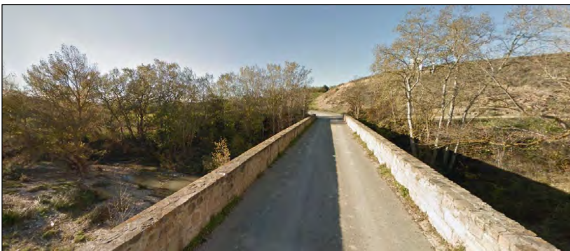
Figura 28. Imágenes obtenidas de GoogleMaps, de los puentes números 1, 3 y 4. La primera fotografía muestra el puente [1] de la carretera NA-127 Sangüesa-Sos del Rey Católico sobre el río Aragón. La segunda fotografía corresponde también a la carretera NA-127, pero esta vez sobre el trazado del río Onsella [puente [3]]. Por último, la imagen inferior muestra un puente antiguo sobre el río Onsella, paralelo aguas arriba al anterior [4].
